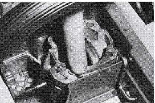
Mise en place de la tuyauterie d'arrivée d'huile de chaîne.
